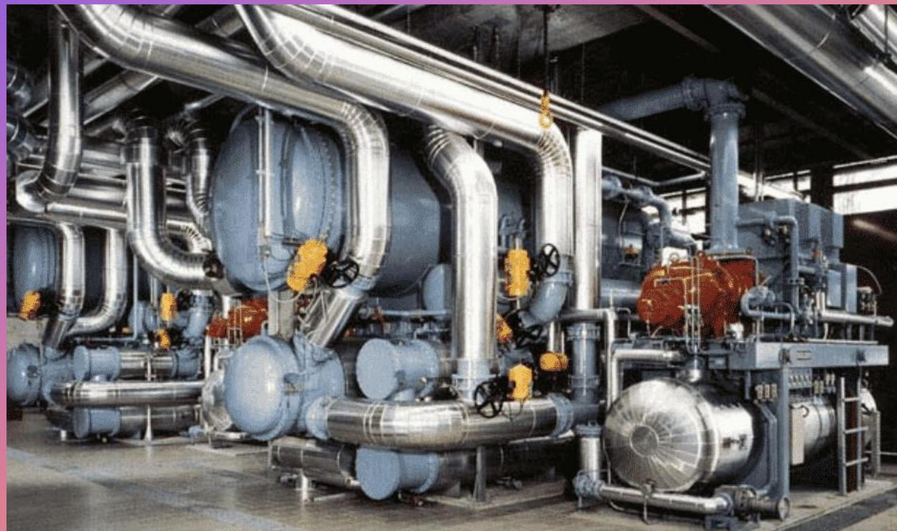
Тепловой насос (ТН) – устройство для переноса тепловой энергии от низкопотенциального источника тепла к системе отопления. До 80% энергии тепловой насос получает из окружающей среды. Это надежная, энергоэффективная и экологичная альтернатива газовым, дизельным, твердотопливным и электродотопительным котлам.
